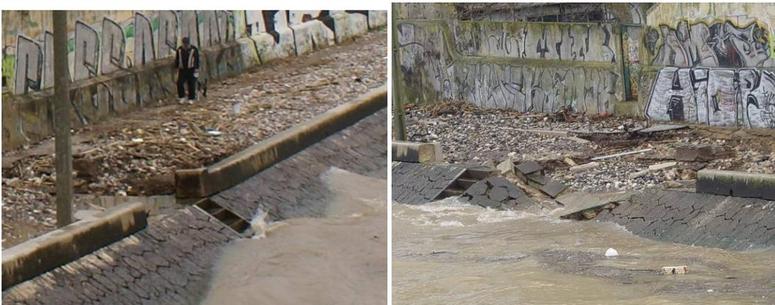
Figura 81 - Inundação e destruição das margens de protecção do Rio Jamor, foto à esquerda no dia 24 de Fevereiro de 2010 e foto à direita no dia 27 de Fevereiro de 2010 (Fonte: GEOTPU)
