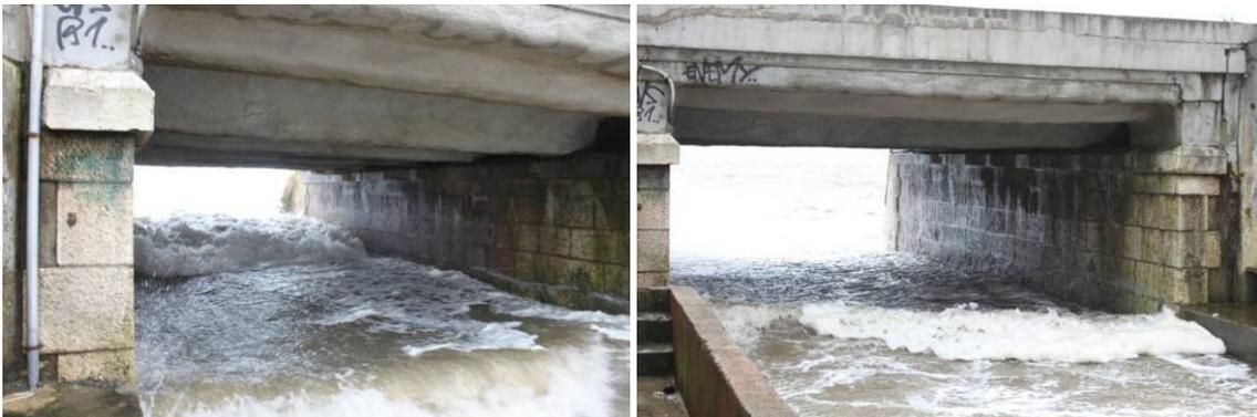
Figura 80 – Inundação da passagem inferior pedonal (Fonte: GEOTPU, 2010)
