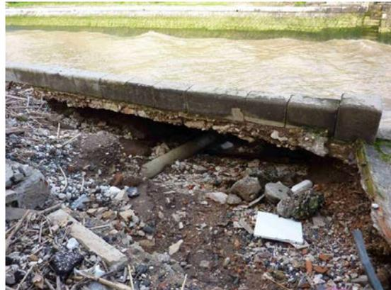
Figura 48 – Erosão do leito de cheias na margem direita do rio Jamor entre a ponte da Av. Marginal e a ponte da REFER - vista para montante
